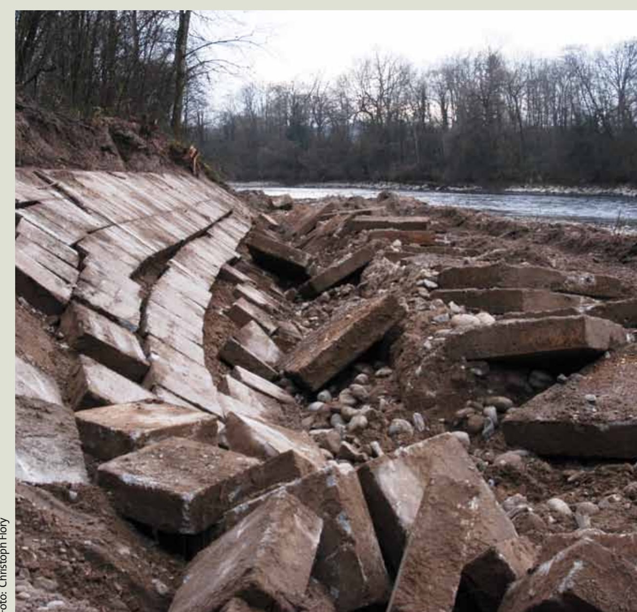
Um die gewünschte Dynamik im Foort einzuleiten, wurden in den Wintern 2003 bis 2005 die Betonblöcke entfernt und zwei Seitenarme gegraben.
