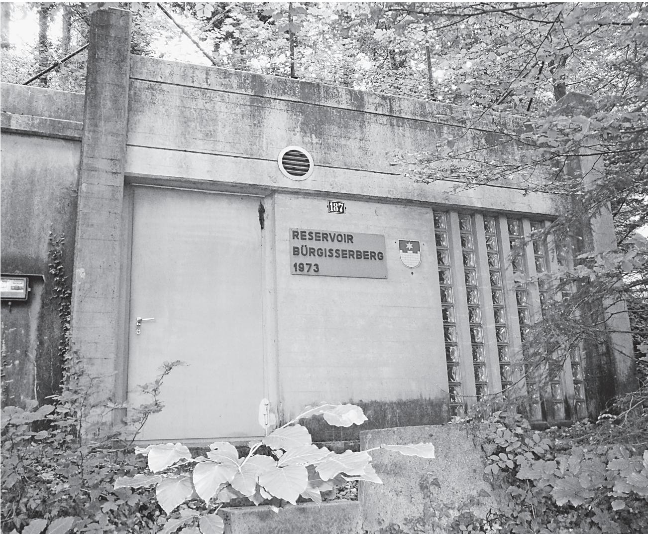
Im Reservoir Bürgisserberg wurden unter anderem die Überläufe der Wasserbecken siphoniert.
