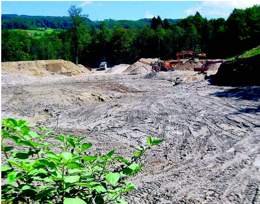
Im Dienst der Natur: Starker Baumaschinen-Einsatz in Reussnähe. SL
