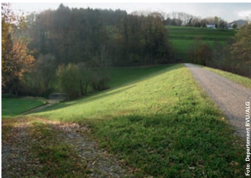
Seit über 20 Jahren erfolgreich in Betrieb: Das Hochwasserrückhaltebecken Greuel oberhalb von Muri fügt sich gut in die Landschaft ein.
