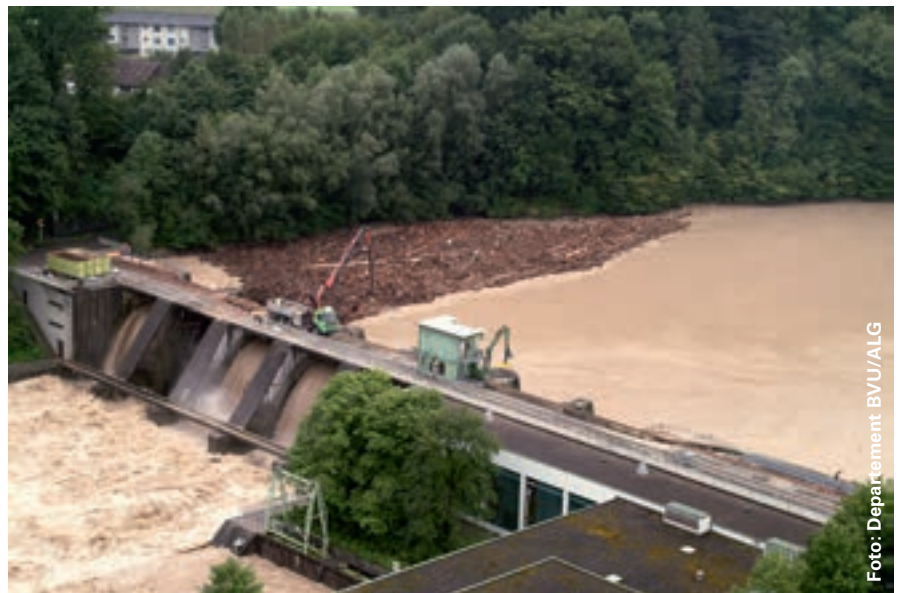
Hochwasser August 2005: Beim Kraftwerk Bremgarten-Zufikon sammelten sich riesige Mengen Schwemmholz an.
