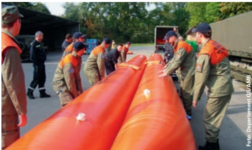
Das Doppelschlauchsystem «Beaver» hat eine Stauhöhe von rund 80 Zentimetern.
