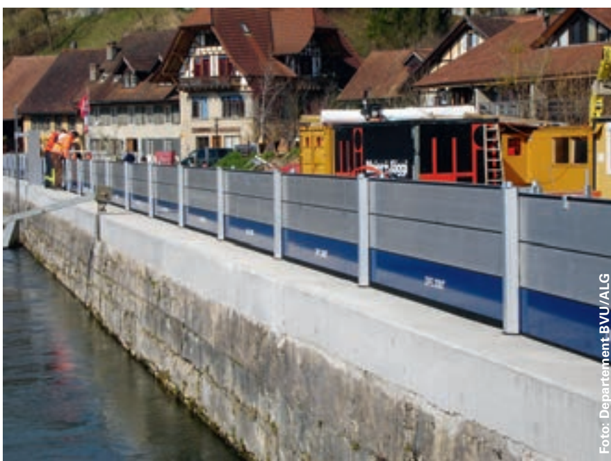
In Unterwindisch werden die mobilen Dammbalken eingebaut.
