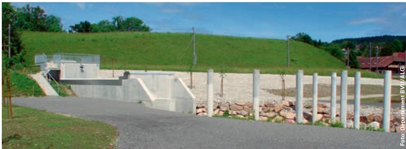
Das Auslaufbauwerk des Hochwasserrückhaltebeckens Moos
