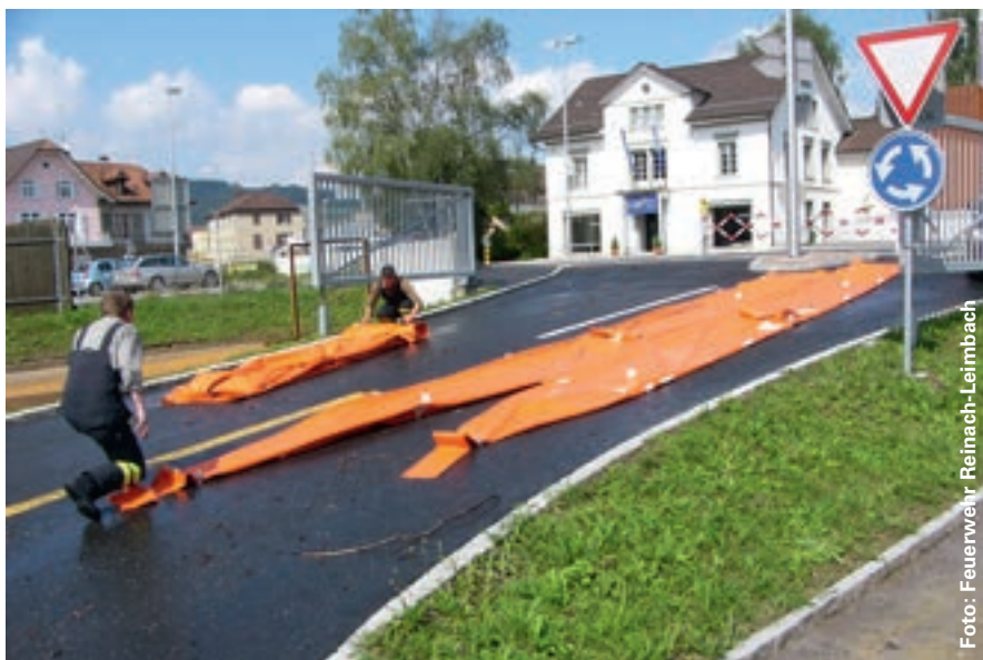
Die mobilen Hochwassersperren vom System «Beaver» sind rasch aufgebaut.
