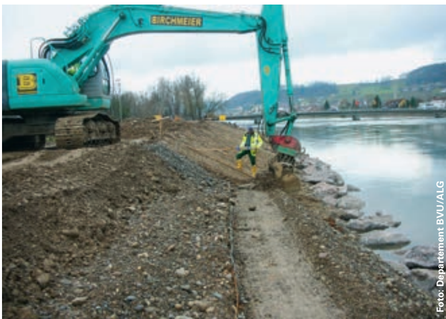
Kleindöttingen: Der Damm wurde um zirka 1,4 Meter erhöht.
