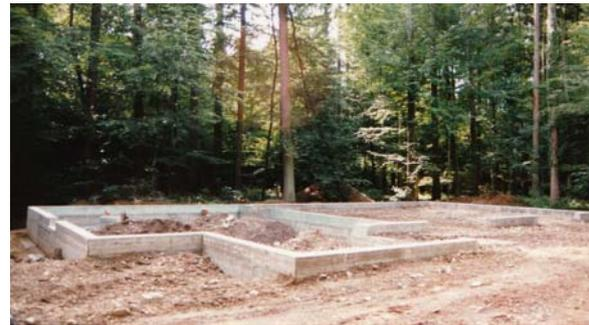
Am 2. Juli war das Fundament fertig betoniert und einige Abende danach konnte man den emsigen Fronarbeitern beim Ausschalen und Reinigen der Bretter zuschauen.
