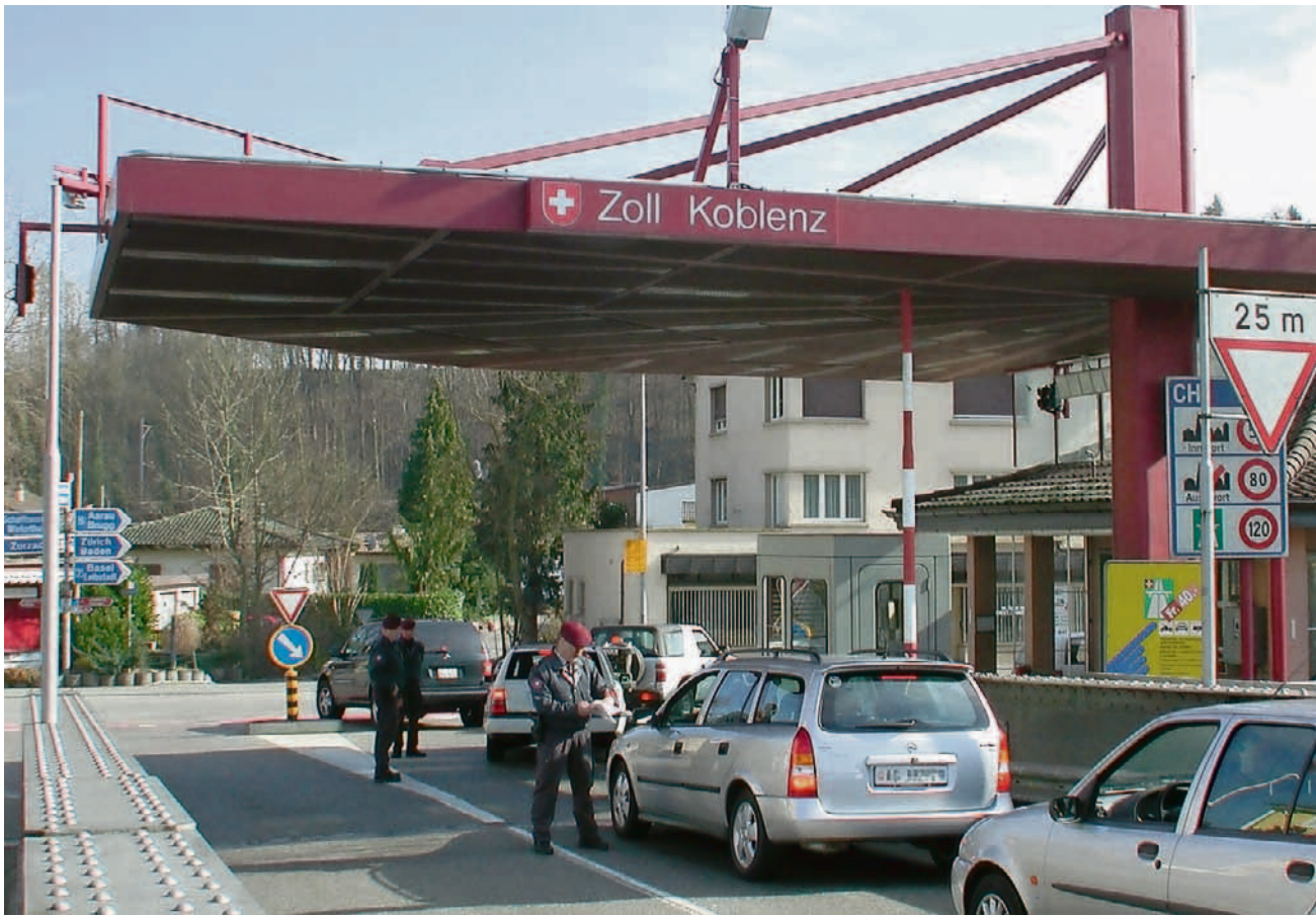
Zoll und Strasse in Koblenz werden neu gebaut, das Linksabbiegen wird aufgehoben.
