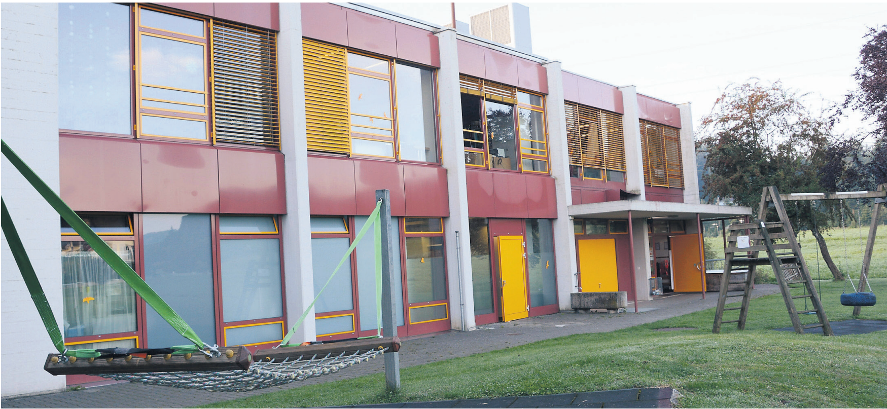
Mit kleinen Anpassungen soll im Schulhaus Lohren mehr Platz geschaffen werden.
