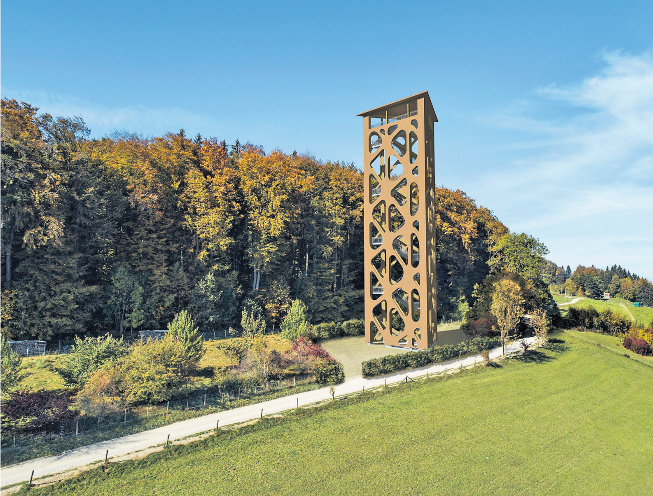
Dem Bau des Hasenbergturms steht nichts mehr im Weg.
