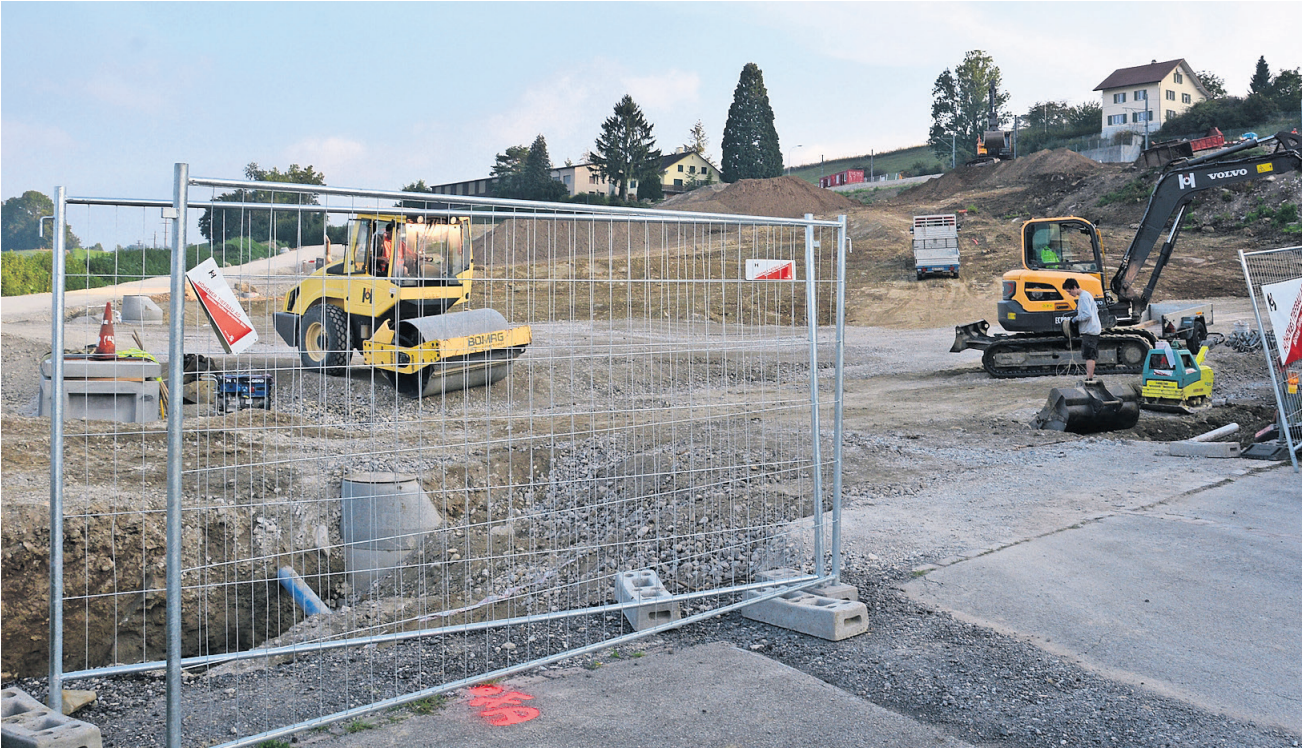
Die Arbeiten in der «Stiegelen» haben begonnen. Die geplanten Wohnungen werden über die Hälfte des neuen Wohnraums ausmachen.
