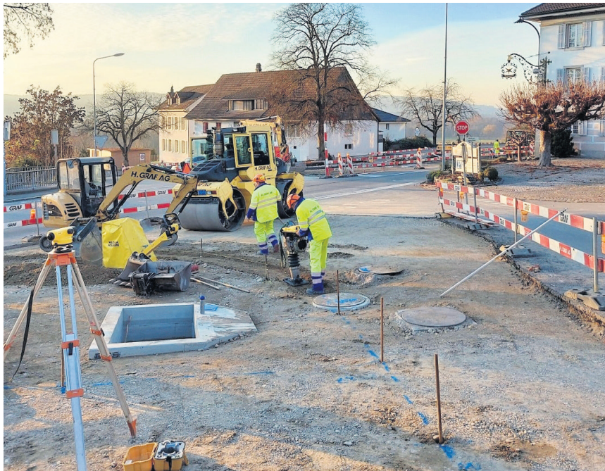
Die Arbeiten an der Kantonsstrasse in Eggenwil sind in vollem Gang.
