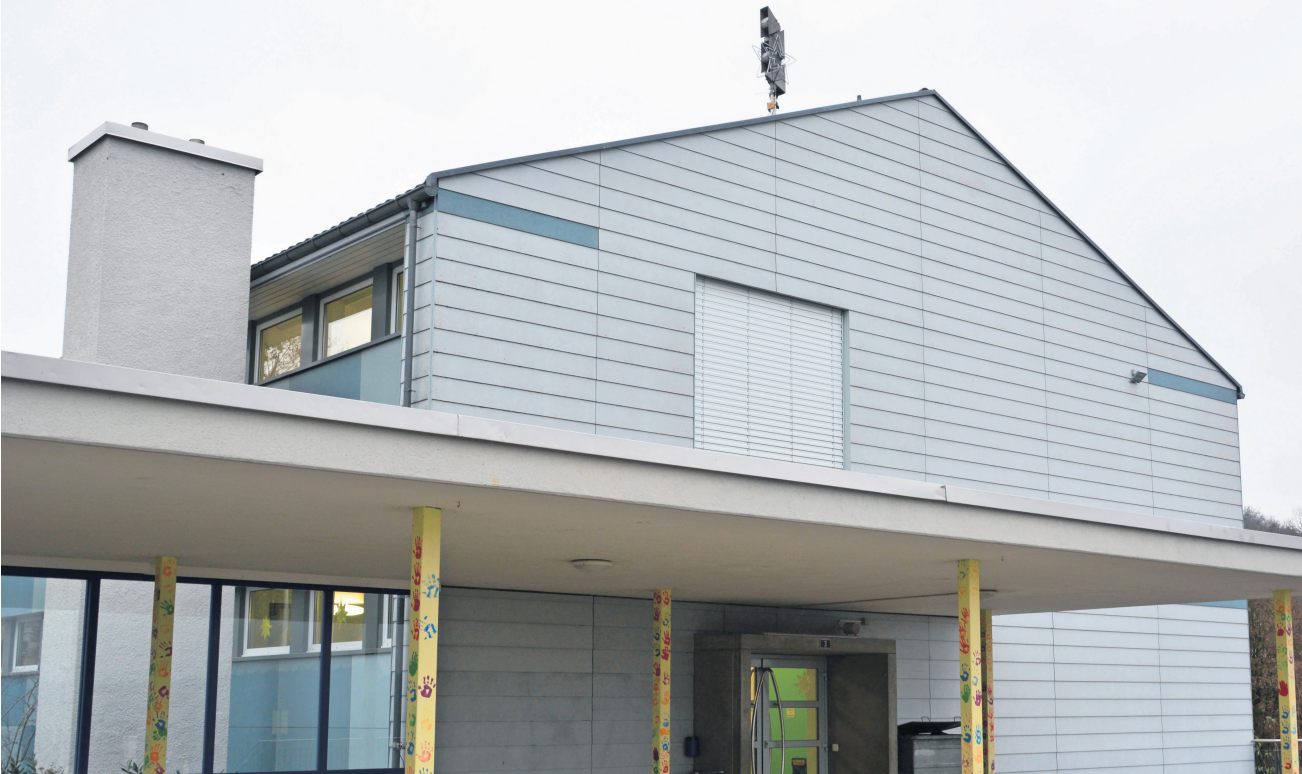
Das Schulhausdach eignet sich für eine Mobilfunkantenne sehr gut. Sie könnte zur Sirenenanlage gestellt werden.
