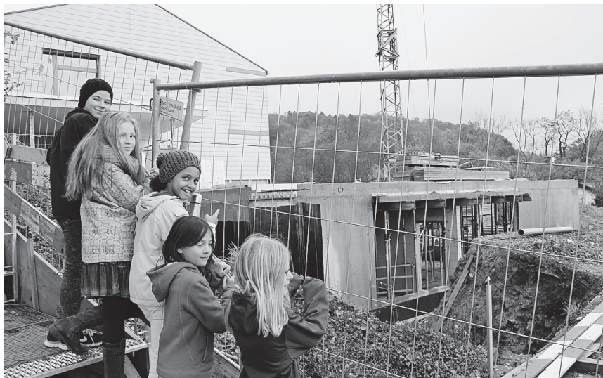
Die Schulanlage wird im Oktober fertiggestellt.
