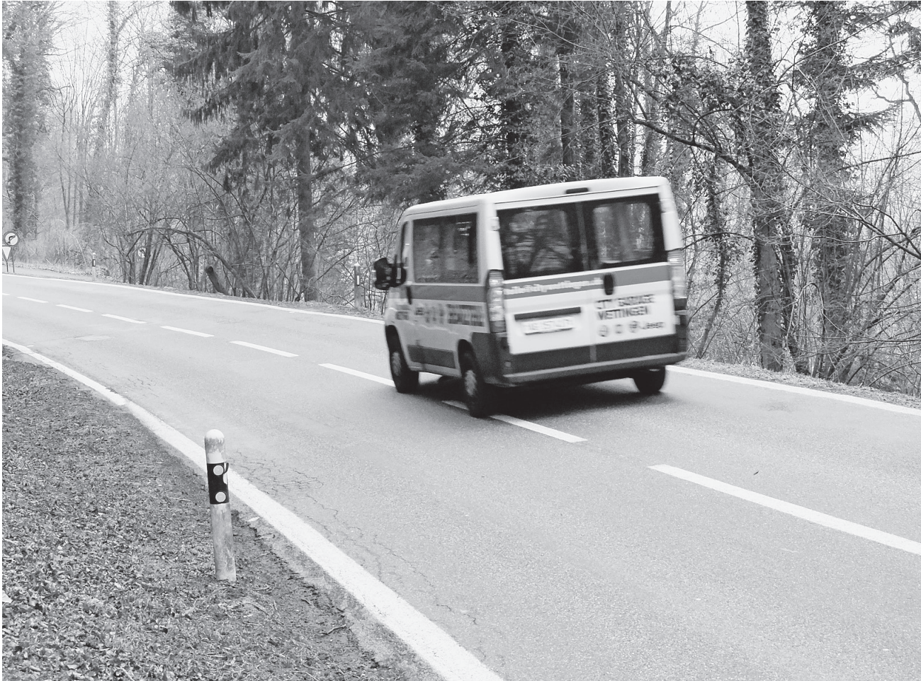
Ausbau der Kantonsstrasse K 271 mit Radweg und Gehweg: Im März/April werden die Rodungen und Sicherheitsholzereien im Wald zwischen Künten und Eggenwil stattfinden. Im April soll der Baubeginn sein.
