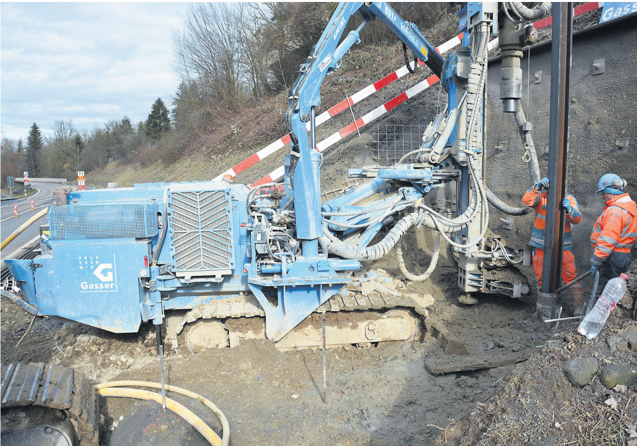
Die Baustelle befindet sich gleich bei der Umfahrungsstrasse schräg unterhalb des Restaurant Freihof.
