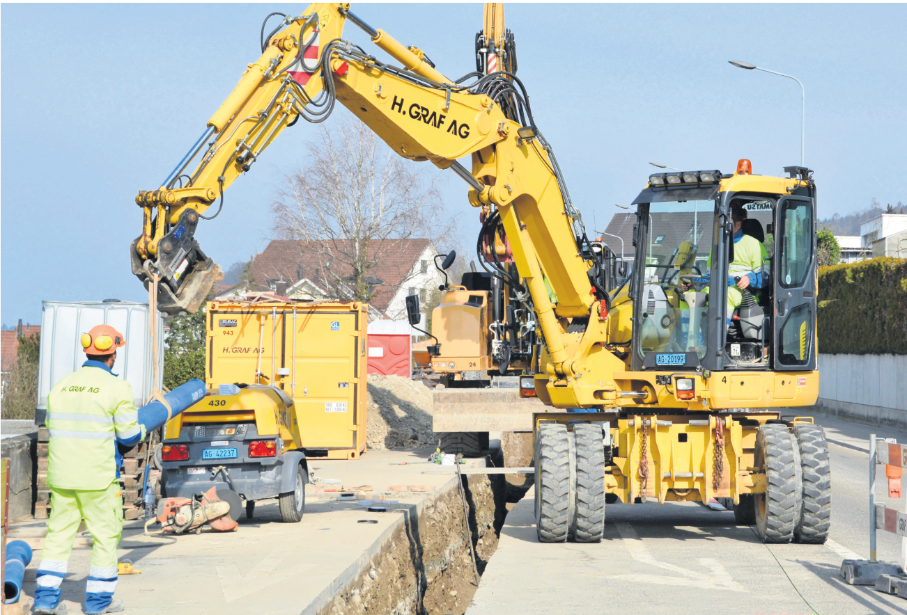
In der Kantonsstrasse werden die alten Leitungen durch neue ersetzt.
