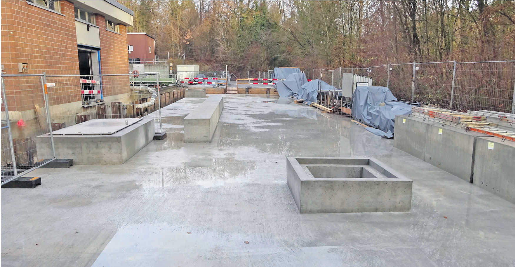
Auch die Decke des neuen Regenbeckens mit seinen beiden Kammern ist bereits betoniert worden. Im Mai wird es in Betrieb genommen.
