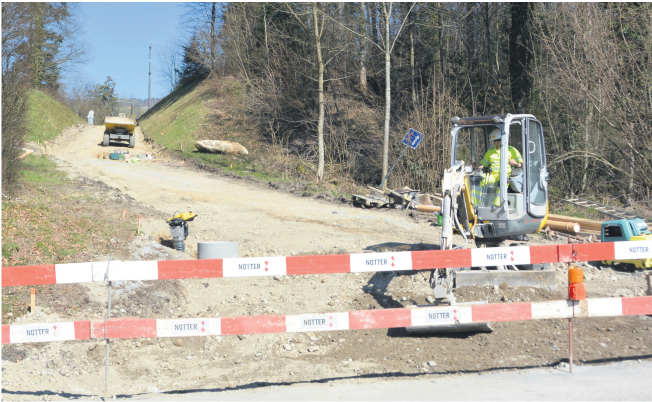
Die Sulzerstrasse ist zurzeit gesperrt. Sie wird auf der ganzen Länge erneuert.
