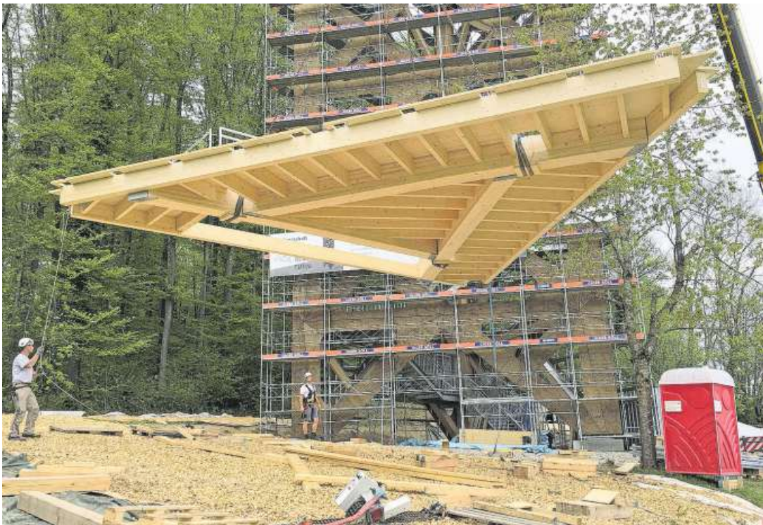
Der letzte Holzboden wird vom Kran auf den Hasenbergturm gehievt.
