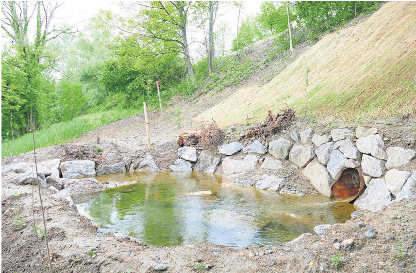
Einige Meter unterhalb der Umfahrungsstrasse fließt der Itenhardbach ins Freie.
