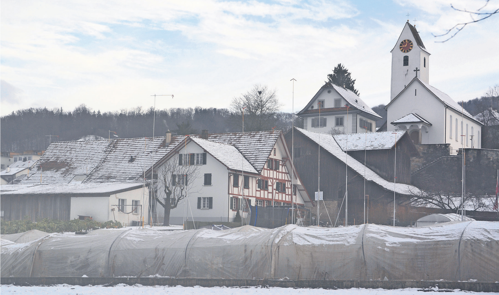
Die neuen Gebäude werden unmittelbar unter der alten Kirche stehen. Das Riegelhaus bleibt dabei erhalten und wird sich in die neue Überbauung integrieren.
