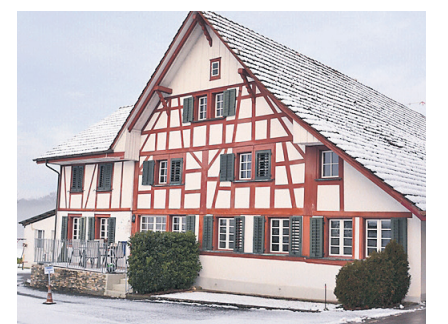
Dieser Teil des Hauses bleibt erhalten. Dazu gibt es zwei neue Häuser.
