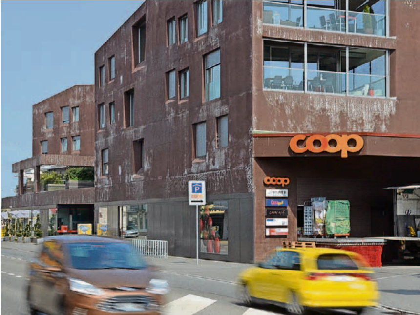
Mit einer neuen äusseren Dämmschicht erhält die Zentrumsüberbauung «Im Cherne» auch einen neutralen, beige-grauen Farbton. ES
