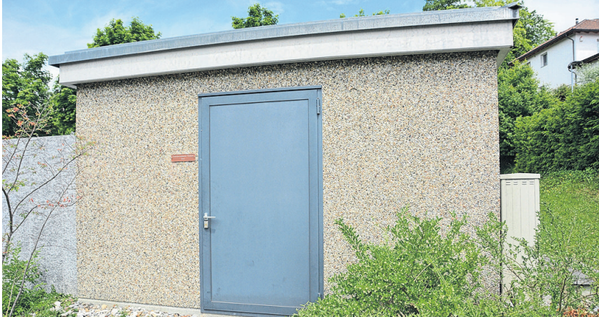
Die Transformatorstation Dorf ist ein wichtiger Teil des Eggenwiler Stromnetzes.
