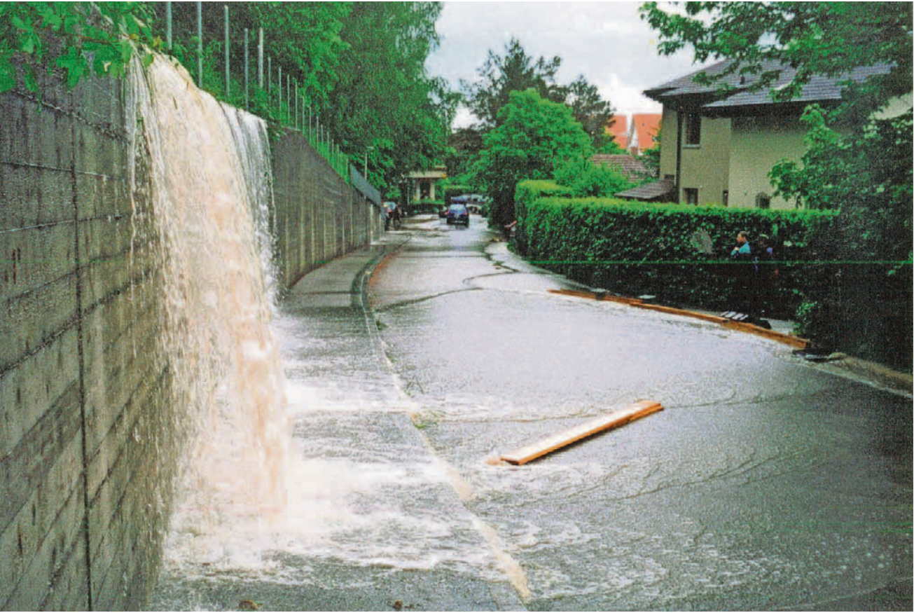
Blick zurück: Überflutung der Kochsmattstrasse unterhalb der Schulanlage Eggenwil vor 15 Jahren. ZVG
