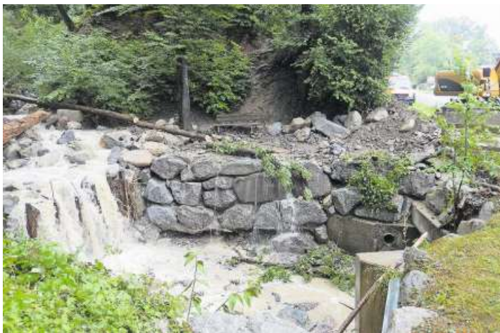
Der Durchlass des Pflanzerbachs oberhalb der Kantonsstrasse wurde am Donnerstagmorgen vom Geschiebe gereinigt.
