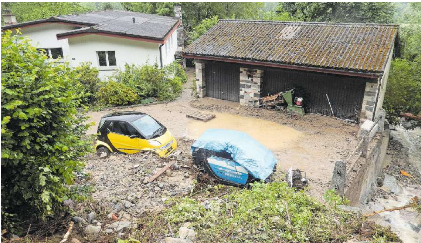
An der Liegenschaft unterhalb der Kantonsstrasse in Eggenwil richtete der Pflanzerbach deutliche Schäden an.
