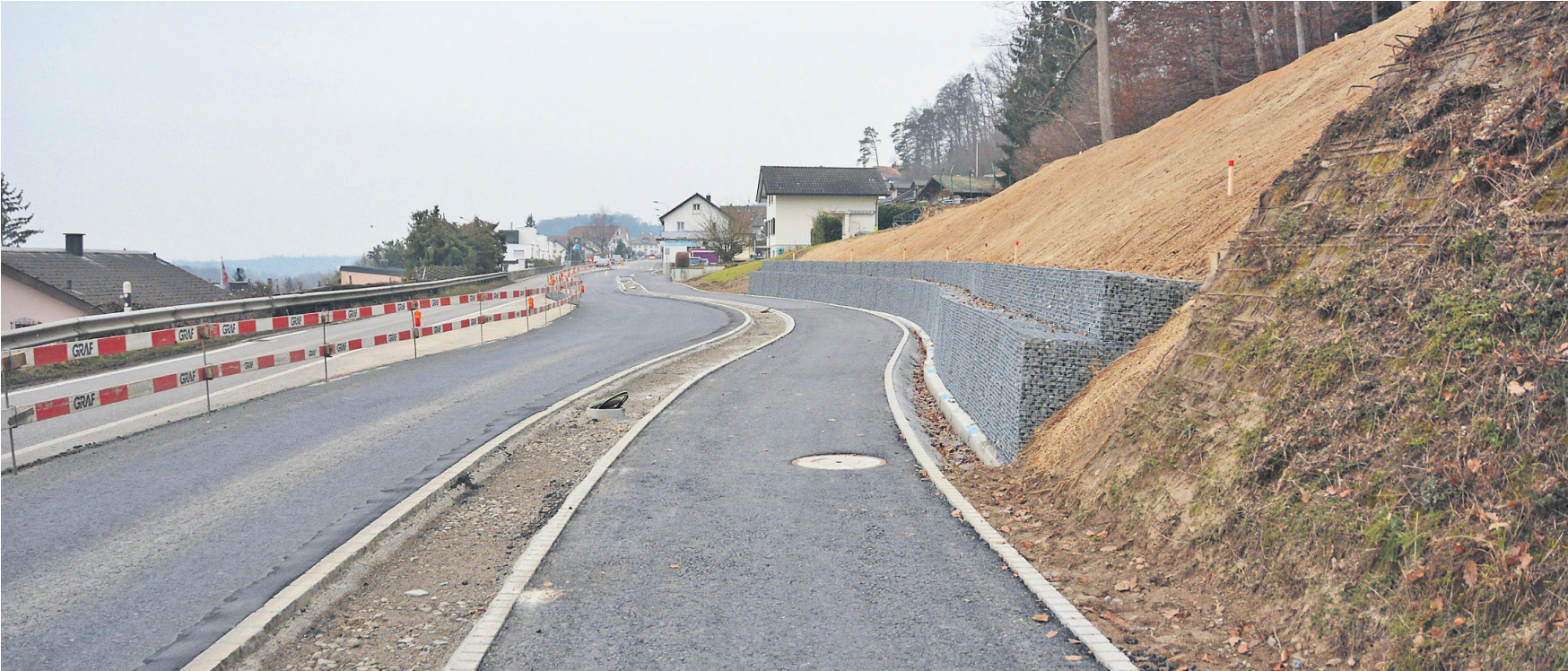
Die Fortschritte der Kantonsstrassensanierung innerorts sind mittlerweile gut sichtbar.
