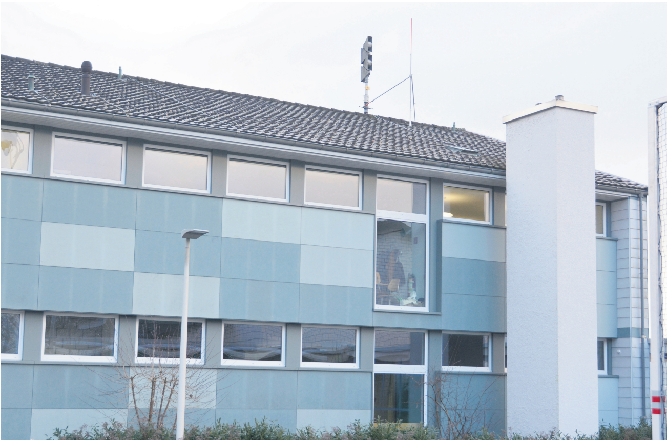
Hier auf dem Schulhausdach soll die neue Mobilfunkantenne der Swisscom installiert werden.
