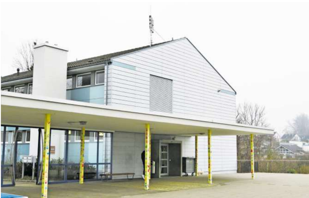
Beim Eggenwiler Schulhausdach plant die Swisscom eine Mobilfunkantenne zu errichten.
