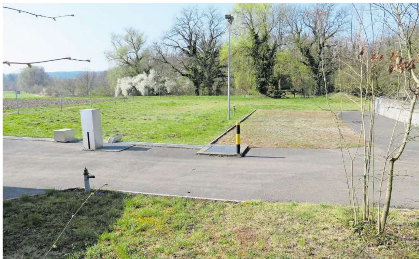
Diese Fläche bei der ehemaligen Eggenwiler Kläranlage wird in eine naturnahe Umgebung umgebaut werden.
