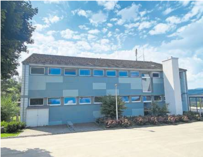
Auf der Nordseite des Dachs werden weiterhin Ziegel bleiben. Bild: rib
