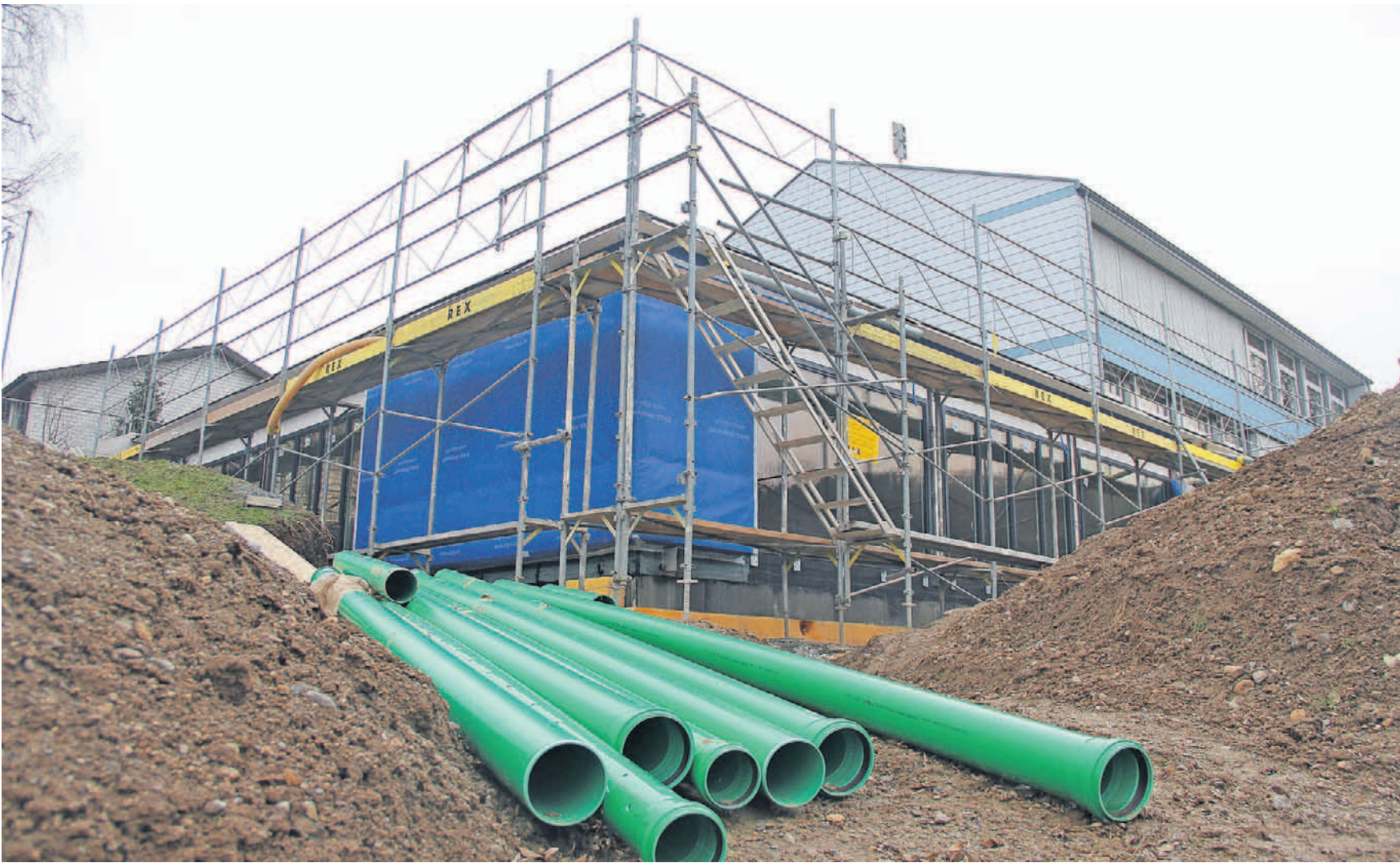
Das Kindergartengebäude (vorne) auf der Grossbaustelle des Primarschulgeländes Eggenwil.
