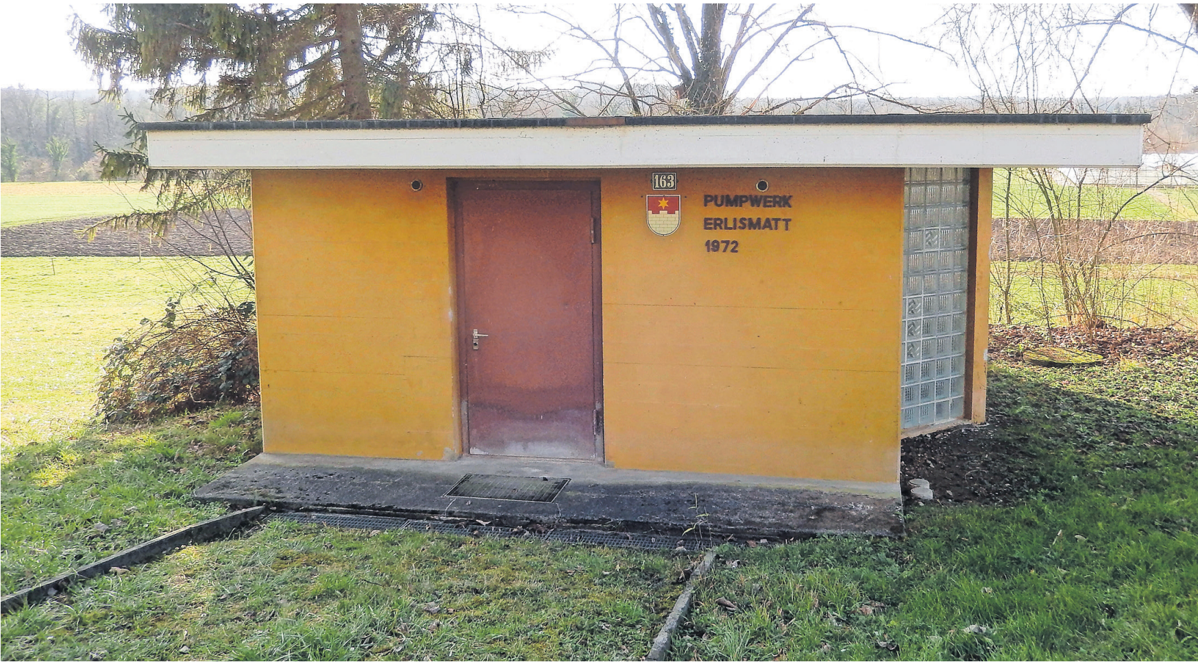
Das Quellwasserpumpwerk Erlismatt soll komplett rückgebaut und dessen Parzellen verkauft werden. Der Wasserpreis wird dadurch deutlich teurer.
