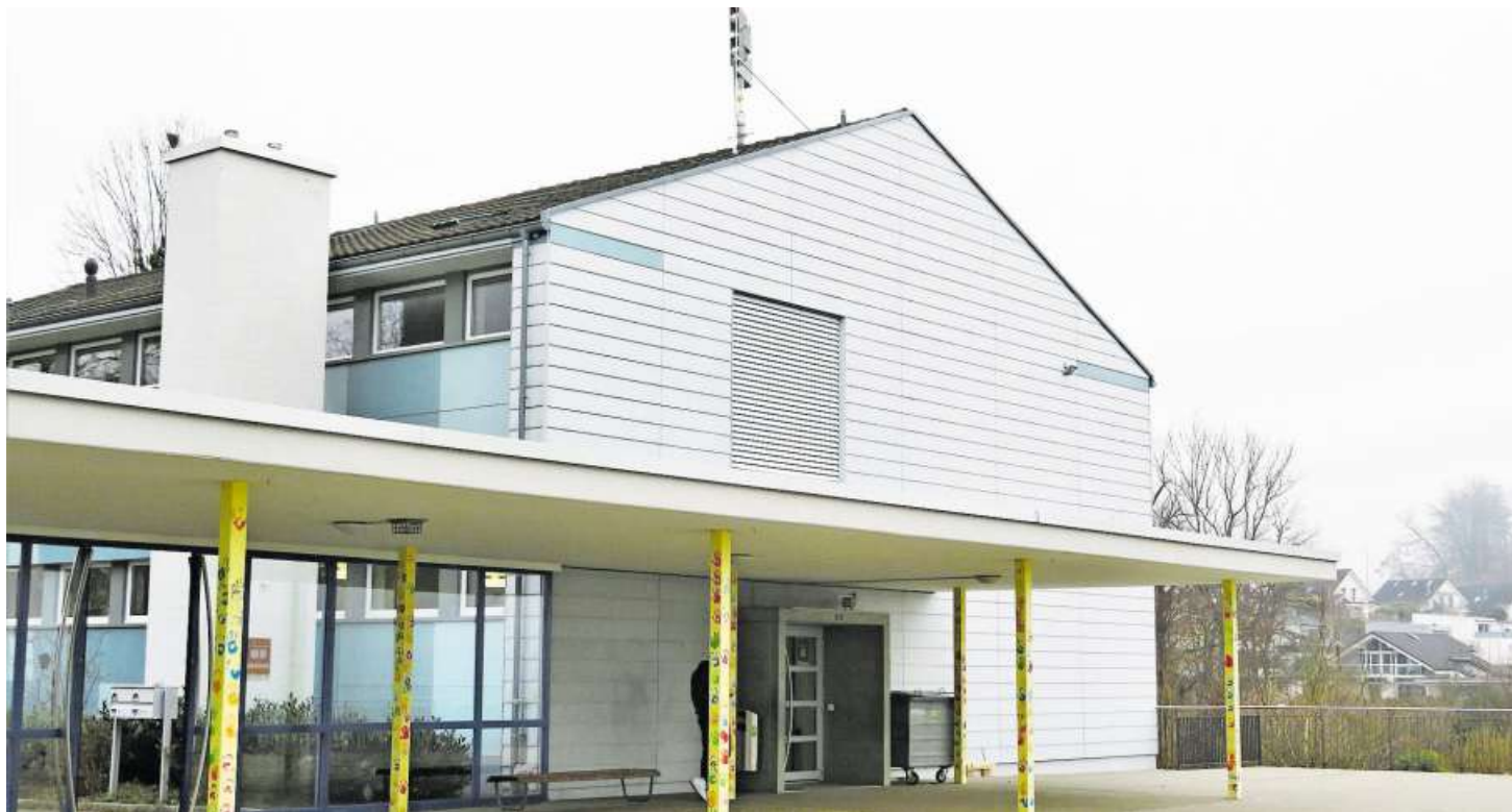
Auf dem Dach des Eggenwiler Schulhaus möchte die Swisscom eine 5G-Antenne bauen.
