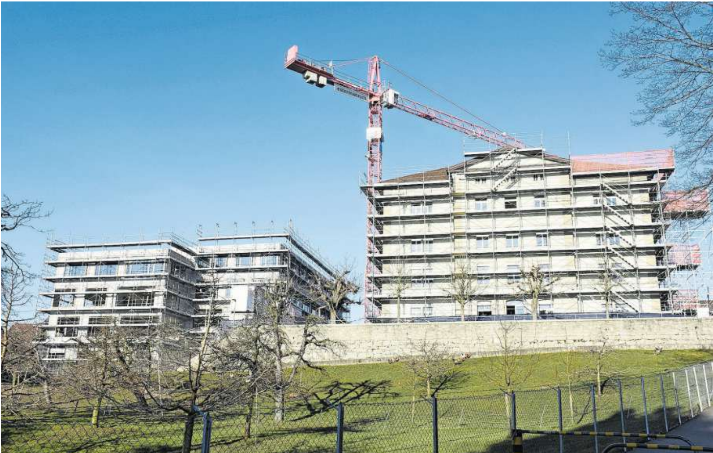
Die Arbeiten des Grossprojektes Schulzentrum Halde in Wohlen schreiten voran. Der Rohbau des neuen Primarschulhauses steht (links) und das alte ist nun eingerüstet und die Sanierung hat begonnen (rechts). Bild: Melanie Burgener/Aargauer Zeitung
