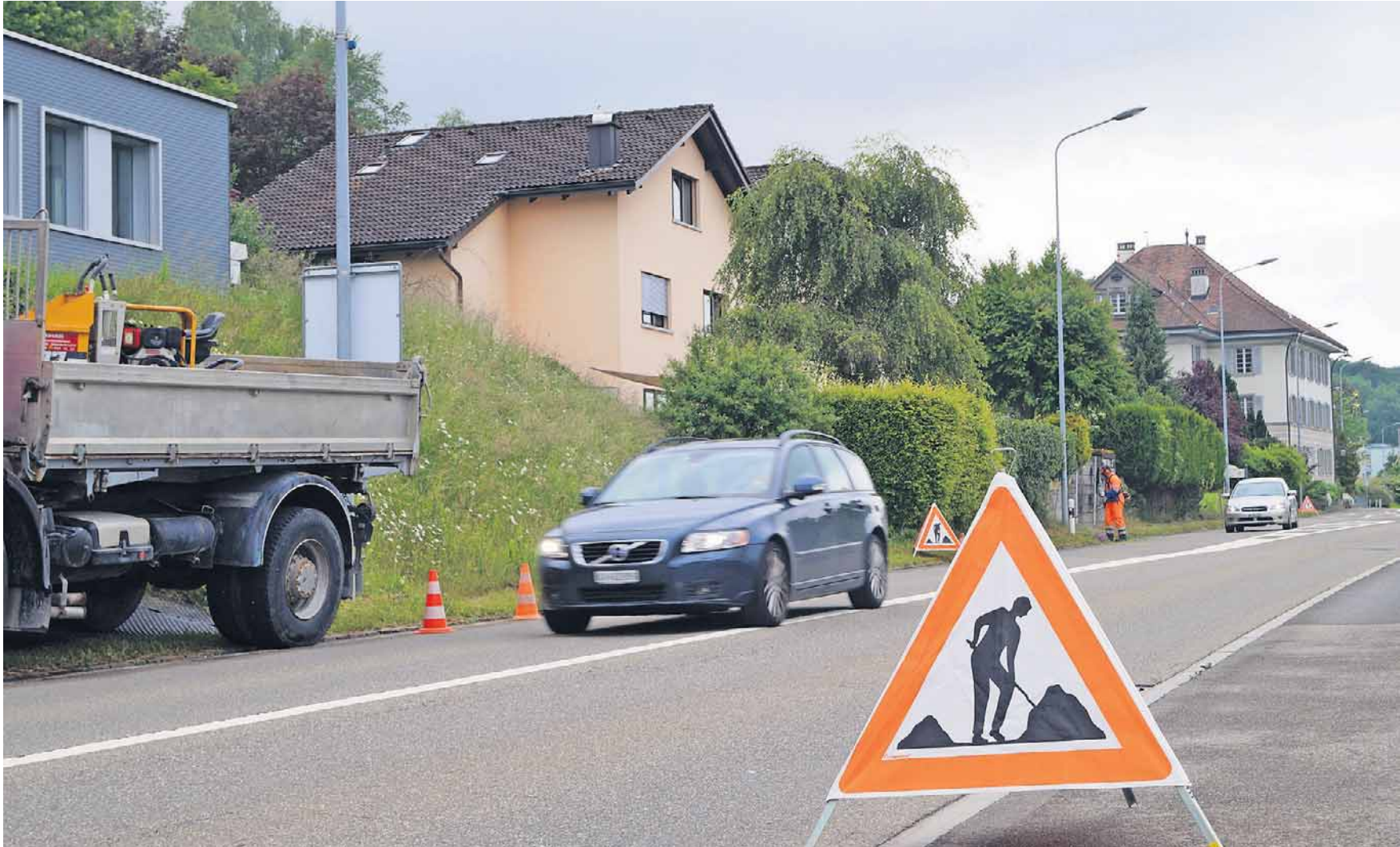
Vorbereitungs- und Installationsarbeiten in Eggenwil deuten auf den bevorstehenden Ausbau hin.
