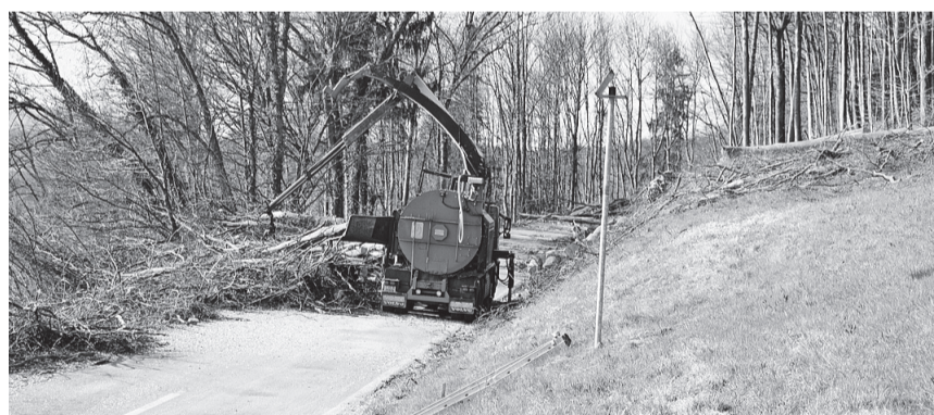
Hier wurde noch gerodet zwischen Eggenwil und Künten. Baustart war gestern. Bild: Archiv
