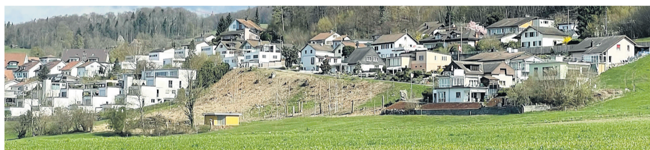
Wo heute das Grundwasserpumpwerk (gelb) steht, werden die zehn Terrassenhäuser eine Baulücke schliessen.
