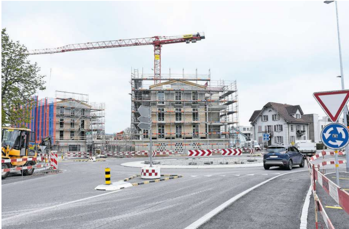
Heute können die Autos bereits um den neuen Kreisel Hirschen kurven. Noch ist das Kantonsprojekt in Merenschwand aber nicht ganz abgeschlossen.
