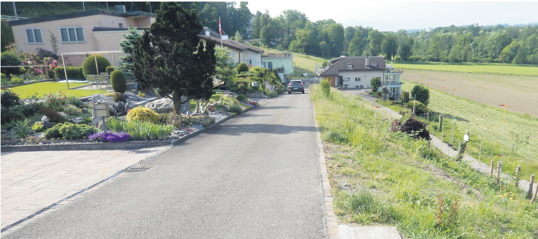
Diese Quartierstrasse soll verbreitert und die Leitungen darunter erneuert werden. Rechts hangabwärts entstehen gleichzeitig zehn Terrassenhäuser.
