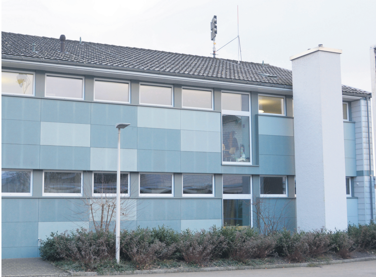
Der Regenwiler Gemeinderat bewilligte den Bau einer 5G-Antenne auf diesem Schulhausdach.
