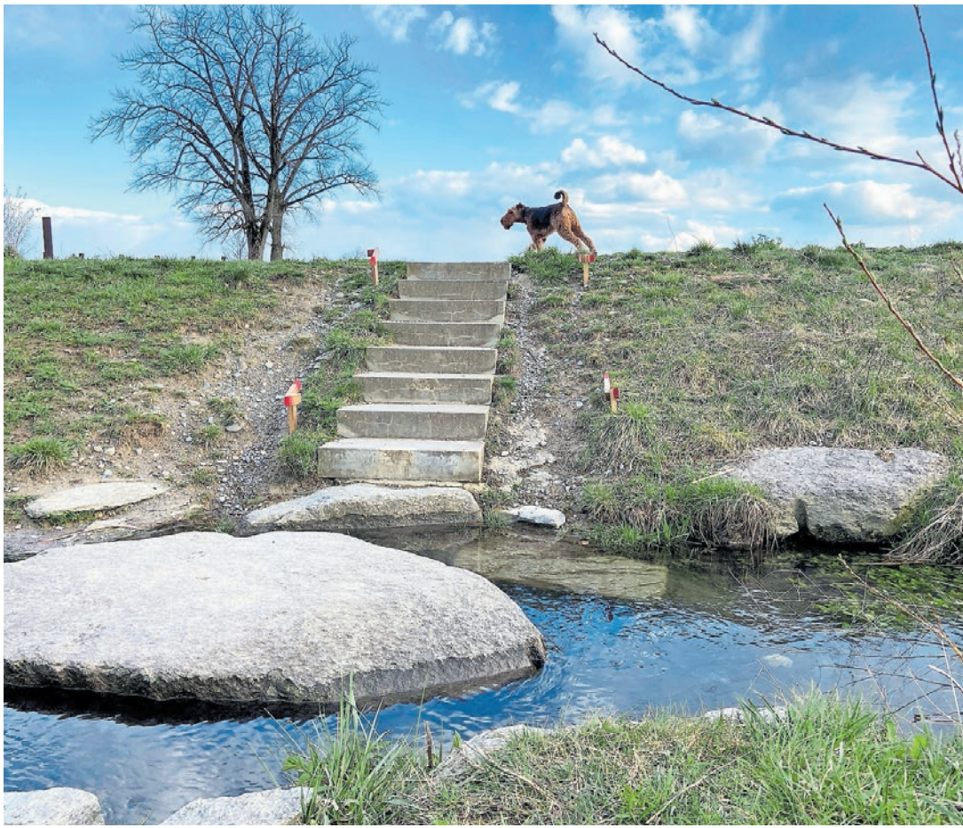
Die Profile stehen bereits: Der Übergang beim Büelisacherkanal wird mit einer Brücke und einem Treppengelände sicherer gemacht. Die Hunde müssen künftig an die Leine.
