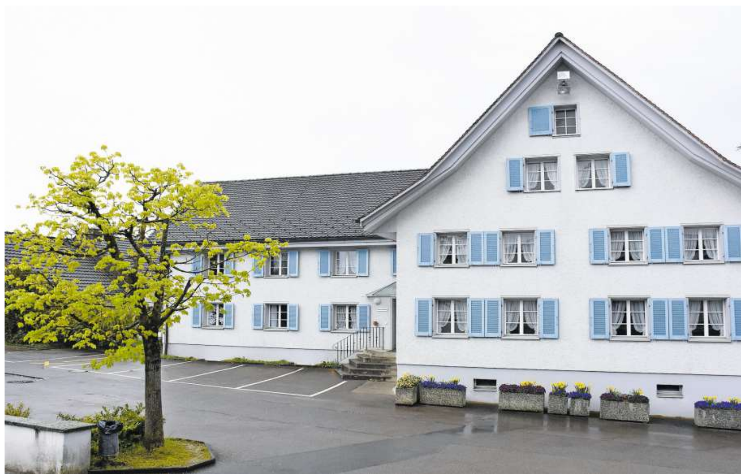
Das Matterhaus wird umgebaut und der Jugend zur Verfügung gestellt. Der Annexbau und das Einfamilienhaus (beide links im Bild) werden abgerissen. Bild: Melanie Burgener
