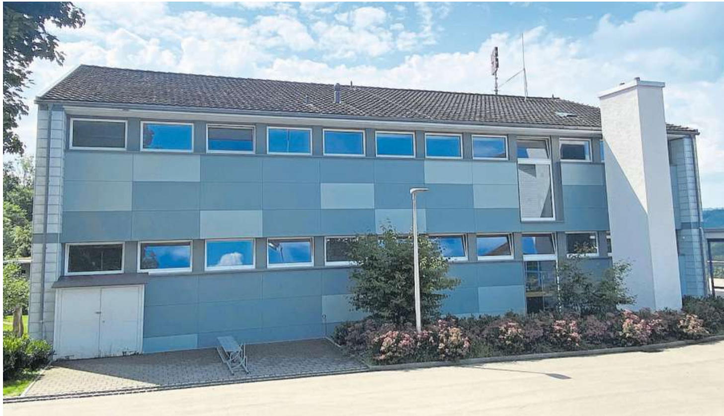
Auf das Schulhaus Eggenwil wird bald eine Mobilfunkantenne gebaut werden.
