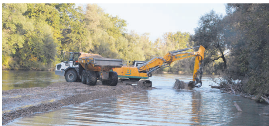
Der Bagger und der Lastwagen sind im Dauereinsatz: Täglich transportieren sie 1200 Kubikmeter Flusskies.
