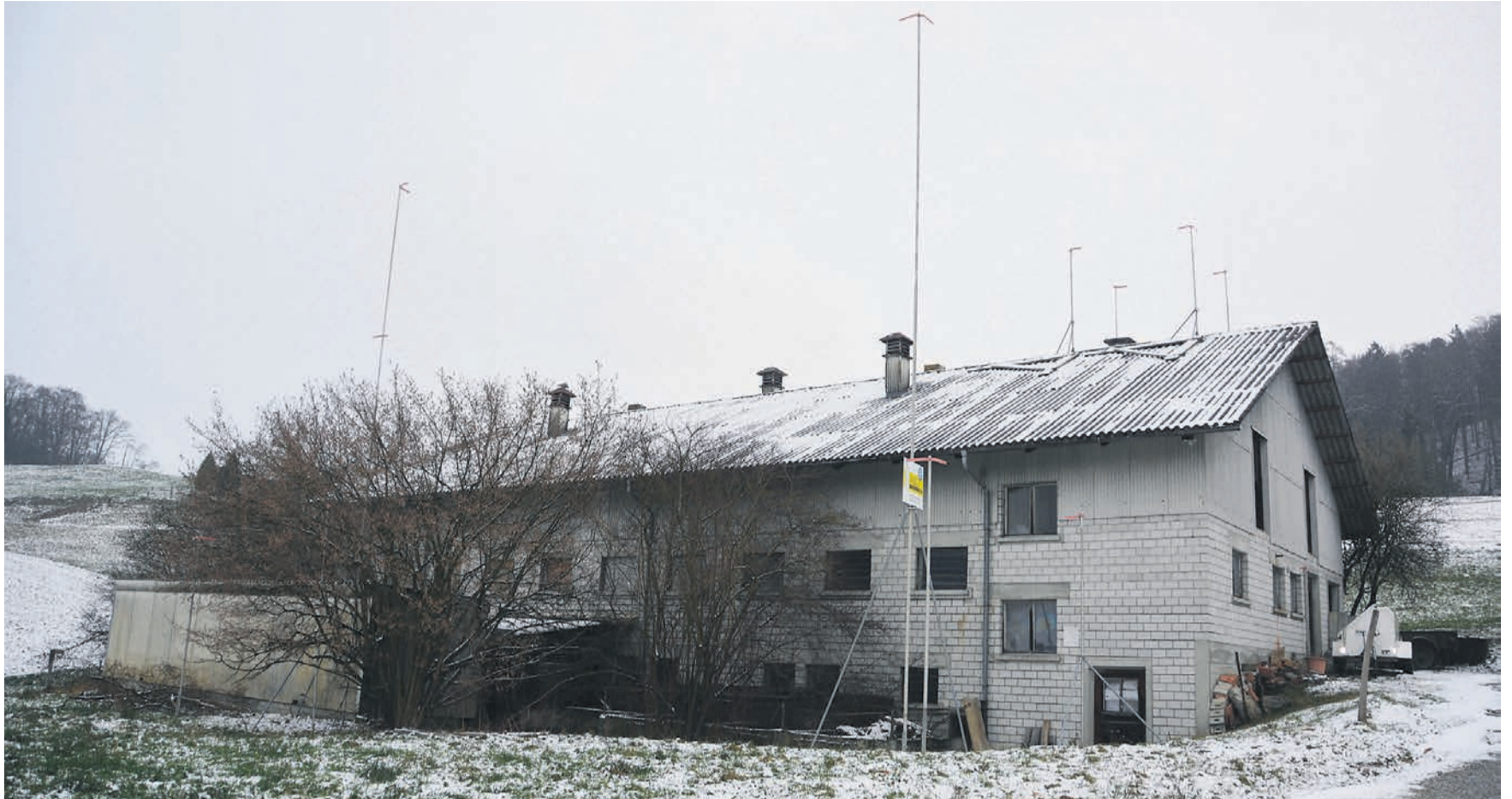
An der Stelle der ehemaligen Schweinemästerei soll bald eine Produktionshalle mit Büros und einer Attikawohnung entstehen.
