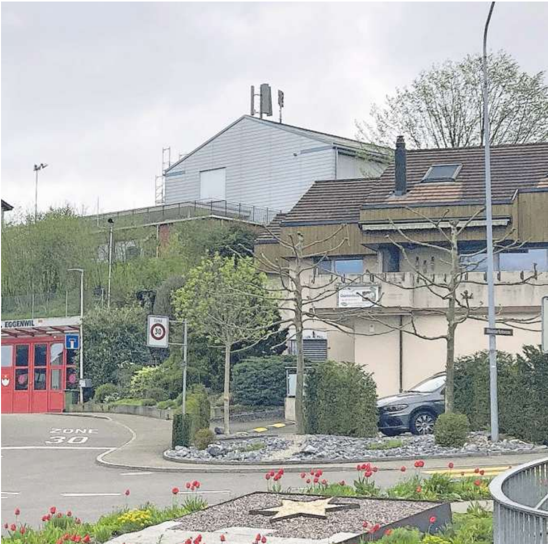
Die Swisscom-Antenne ist, weitherum sichtbar, nun auf dem Schulhaus Eggenwil montiert. Bild: zvg
