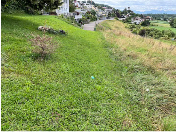
Abbildung 1: Bereich der Sondage S1, Blick nach Osten.
