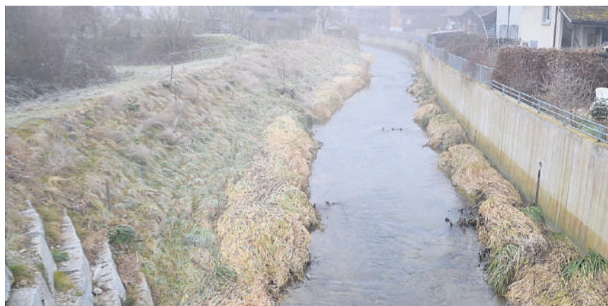
Bis zur Mattenhofbrücke ist der Hochwasserschutz in Jonen gewährleistet.
