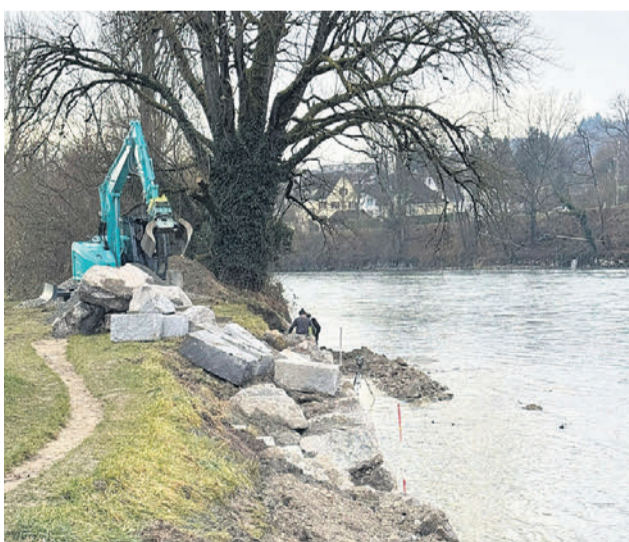
Rund zwei Wochen lang hat der Bagger die Steine puzzleartig...
