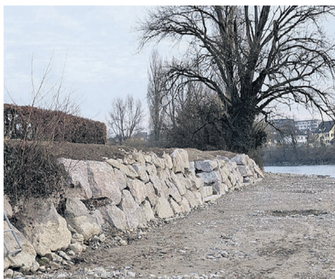
... zu einer neuen Mauer geschichtet.
