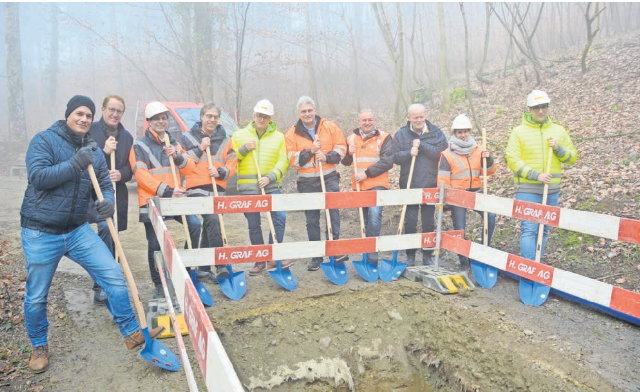
Im Februar 2023 erfolgte in Eggenwil der Spatenstich für Wasseranschluss an den Regionalen Wasserverband Mutschellen. Die Wasserversorgung ist seit Ende dieser Bauten besser gesichert. Allerdings haben diese jetzt auch Auswirkungen auf die verursachten Kosten der Wasserversorgung.
