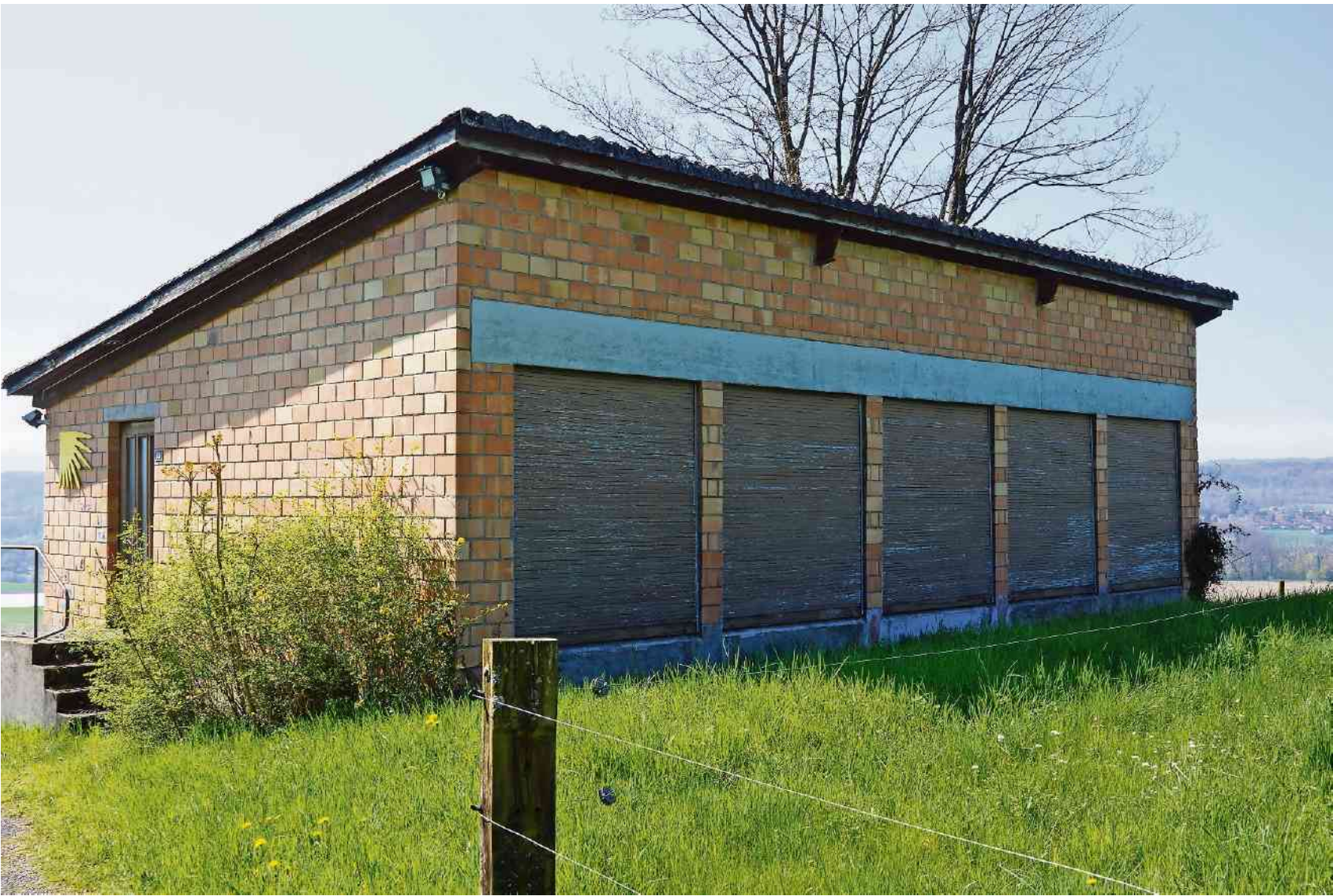
Hier lagen die Schützen nebeneinander, bis 1999 die 300-Meter-Schiessanlage stillgelegt wurde. Jetzt wird der Kugelfang saniert.
