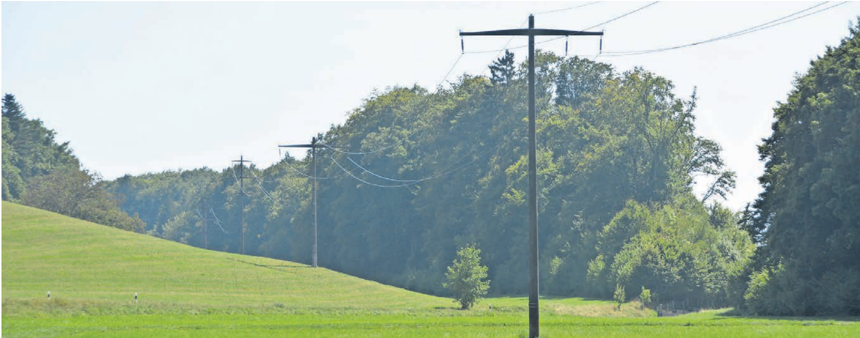
Diese Stromleitungen wird wohl im Winter 2026/2027 zurückgebaut.
